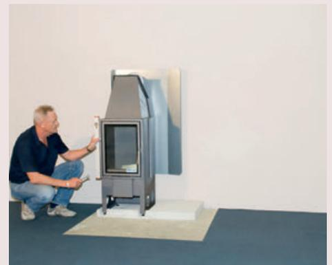
Kamineinsatz mit Wasserwaage einrichten
